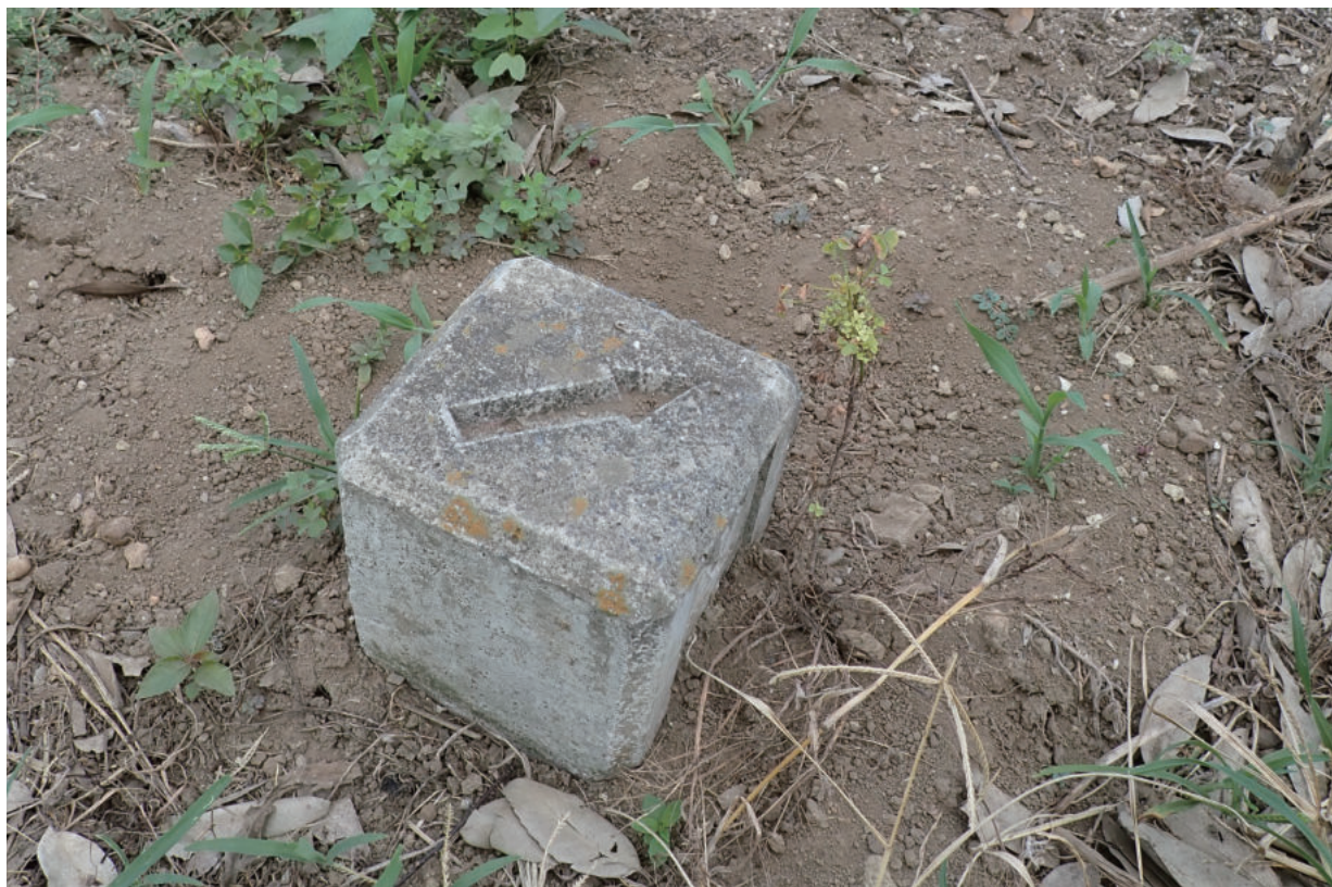
境界標 (栃木県・下野薬師寺跡)
