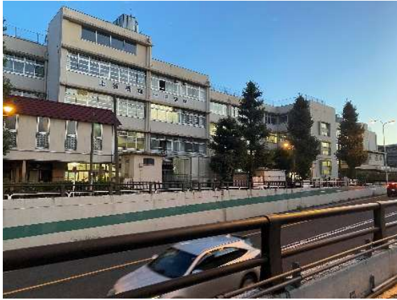
①環状七号線から正門を見る
