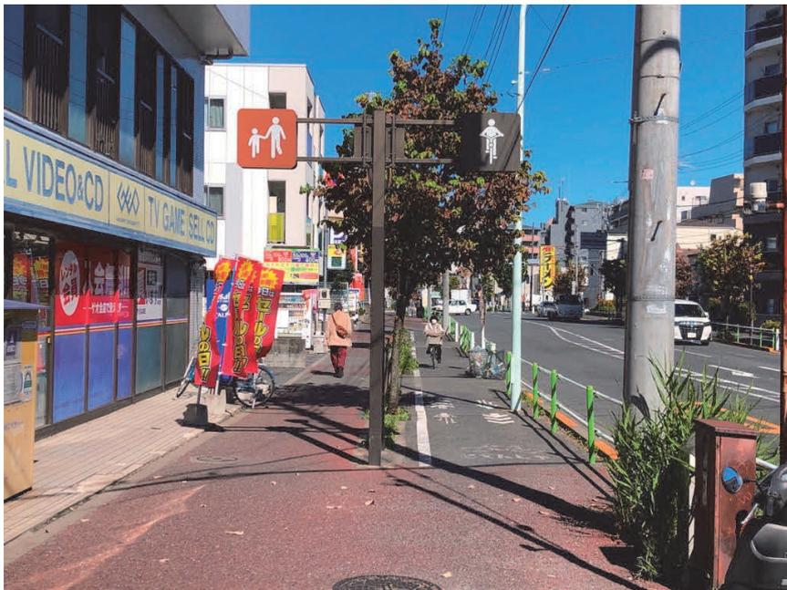
写真：歩行者と自転車の通行位置を分離した自転車歩行者道の例（高島平一丁目）
