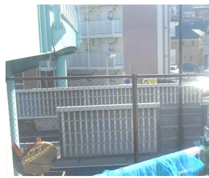
■遮音壁■ 遮音壁を設けることによって回り込む音のエネルギーが小さくなります。
