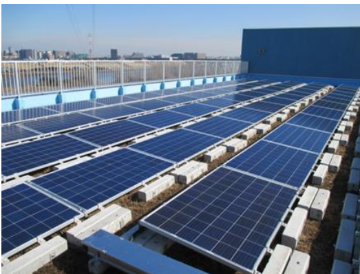
■太陽光発電システムの設置が完了したリサイクルプラザの屋上の様子
