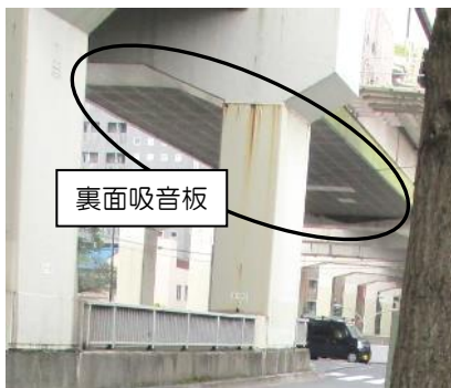
■裏面吸音板■ 裏面吸音板は、下からの音の反射音を低減させる働きがあります。
