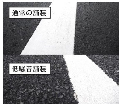
■低騒音舗装■ 車が走行する際の接地音やエンジン音の路面反射を吸収・低減させます。
