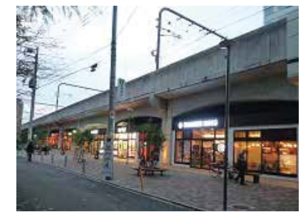
三田線高架下の再整備
