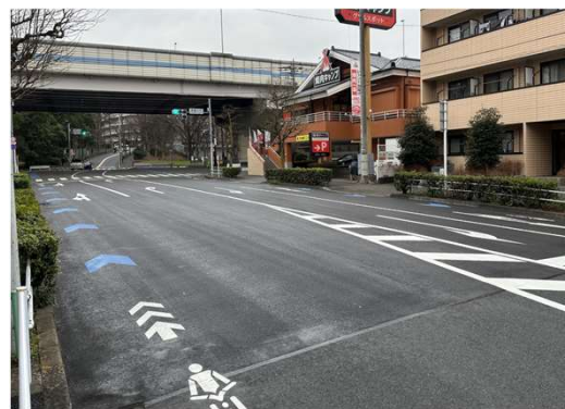
施工後（南側 首都高付近）
