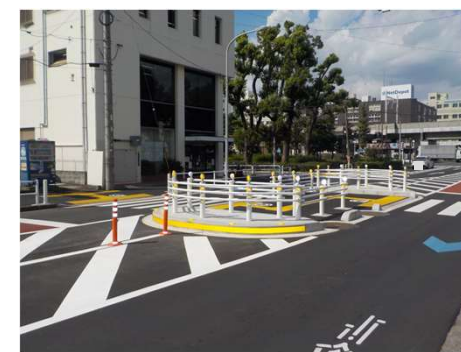
施工後（北側 高島通り側）
