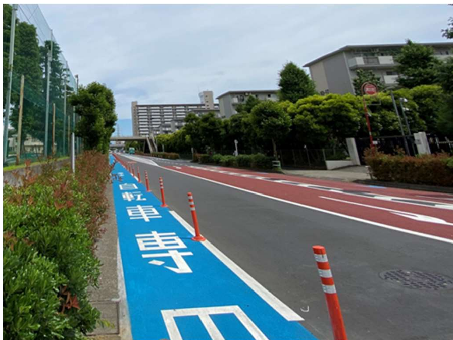
施工後（北側 高島通り側）
