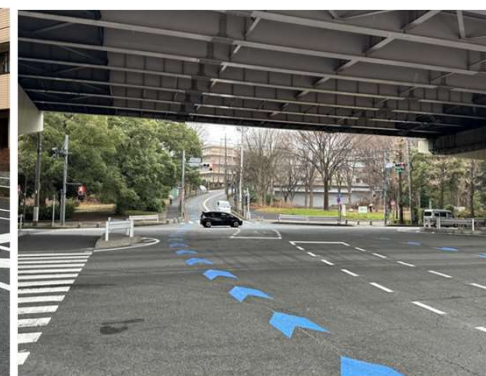
施工後（南側 首都高下）
