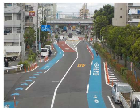
施工後（北側 高島通り側）
