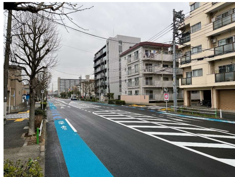
施工後（赤塚公園通り南側 至 首都高速道路）
