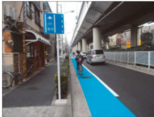
板橋区前野町の整備例
