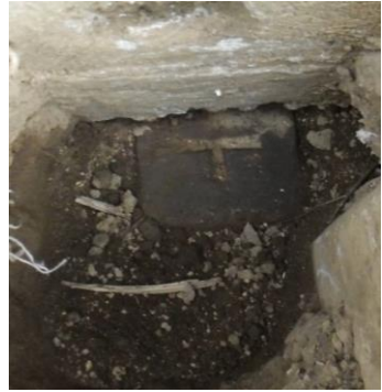
P2 民コンクリート杭
