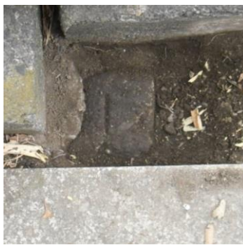
P1 民コンクリート杭
