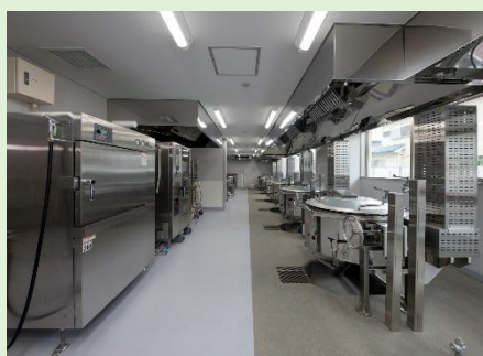
板橋第十小学校 給食室①
