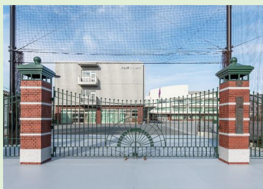
板橋第十小学校 正門
