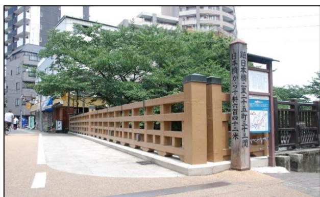
インフラ資産 (板橋)
