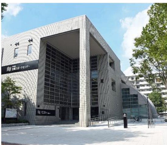
植村記念加賀スポーツセンターリニューアル
