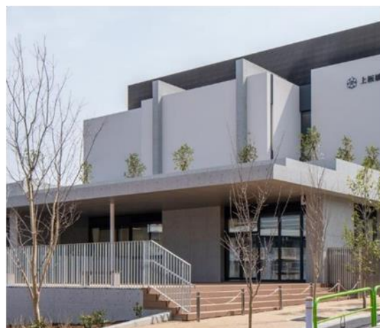
魅力ある学校づくり上板橋第二中学校改築完了
