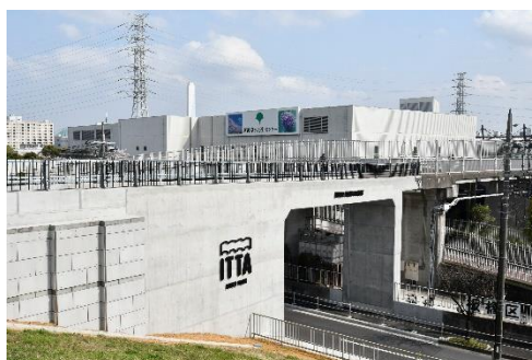
「板橋区かわまちづくり」連絡通路
