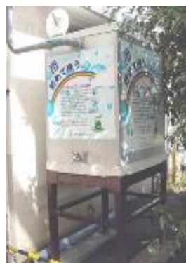
■ 雨水貯留タンク 桜川小学校
