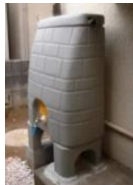
■ 雨水貯留タンク
