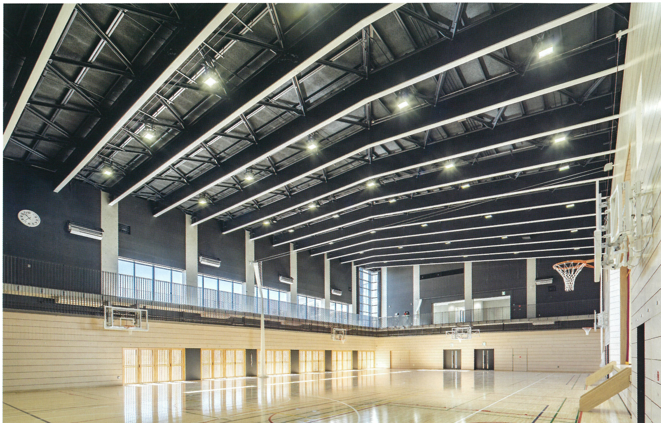
体育館内観。北側近隣に配慮し屋根に勾配を付け鉄骨の接合部のボルトをなくすため現場溶接した大梁
