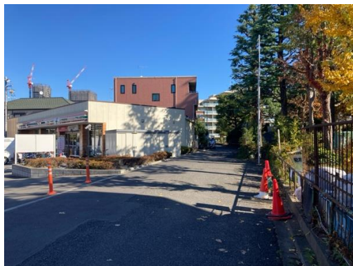
⑦板橋公園北側の状況
