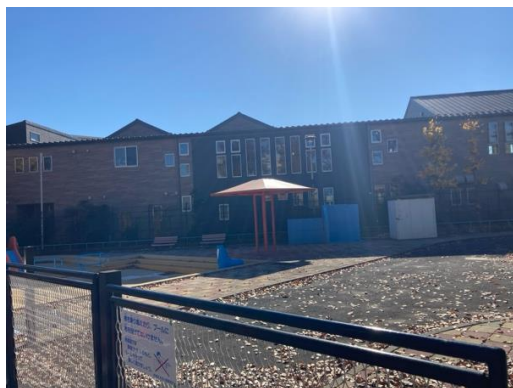
⑤板橋公園南側の状況
