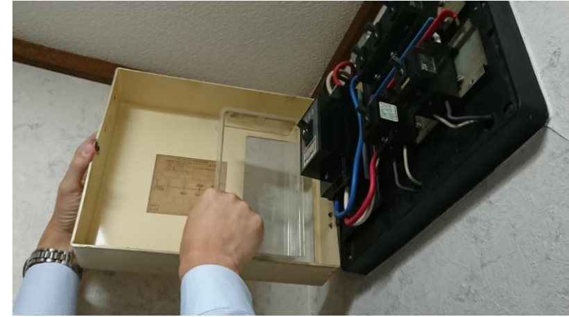
③ 分電盤の蓋を開け、透明部分のカバーを内側から外す。 * 上下左右の4点留めになっている。
