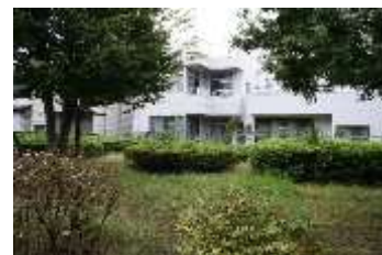
③住宅沿いのフェンス
