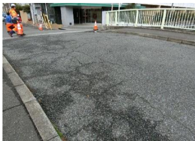
成和橋の工事前
