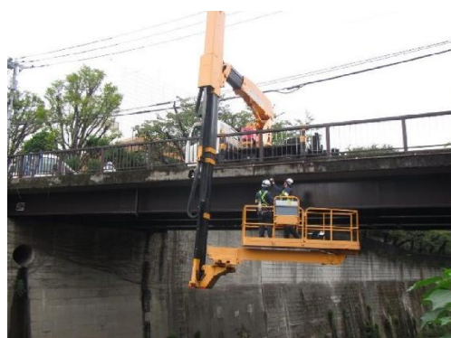
加賀橋（橋りょう点検車による点検）
