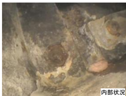
芝原橋（ファイバースコープカメラによる点検）
