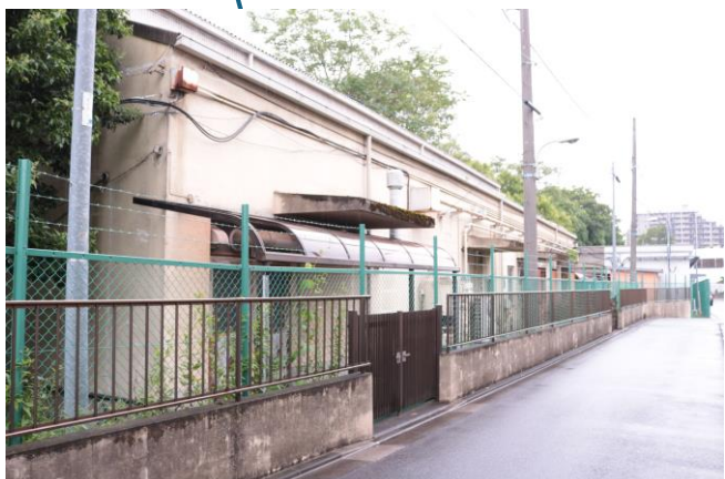
爆薬物理試験室外観
