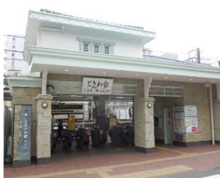
東武東上線とさわ台駅舎 (常盤台一丁目)
