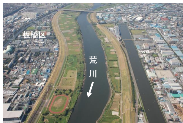
荒川板橋区地区 現地写真（空撮）
