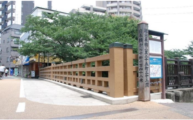
インフラ資産（板橋）
