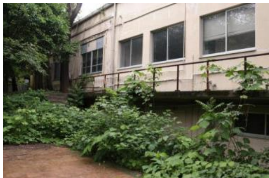
南側から建造物を望む様子
