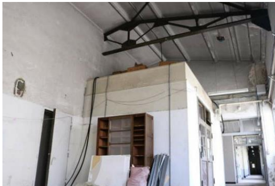
D棟 5号室付近
