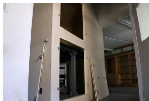
宇宙線観測機器が設置されていた加温室
