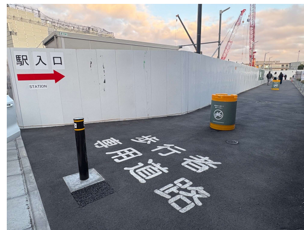
新たに整備した歩行者用通路
