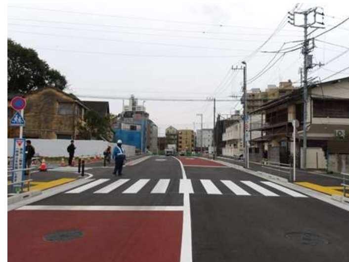
工事中の安全対策：横断歩道への警備員の配置
