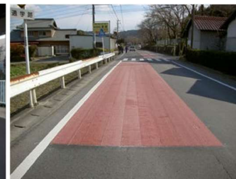
車線部のカラー舗装例
