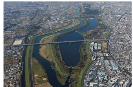
埼玉県にある荒川第一調節池※
