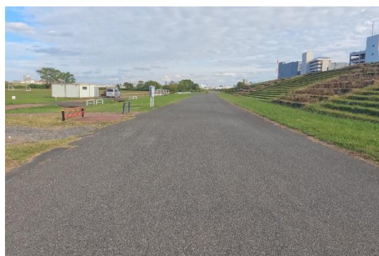
緊急用河川敷道路
