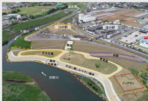
川の駅と道の駅からなる複合施設
