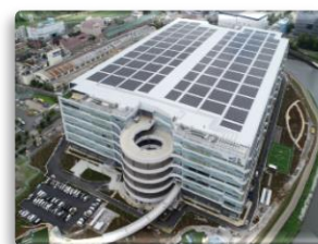
再生可能エネルギー100%電力の地産地消 (MFLP LOGIFRONT 東京板橋)
