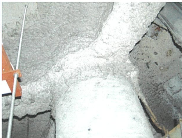
鉄骨耐火被覆
