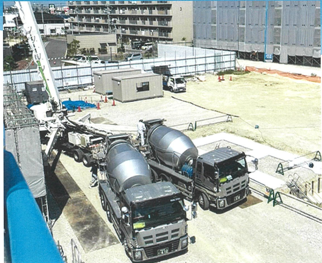
コンクリート打設 (参考写真)
