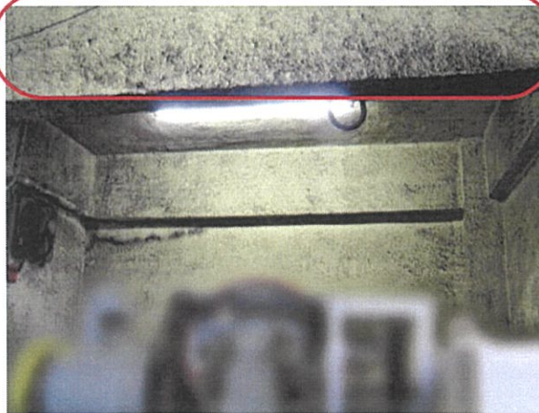
機械室吸音材
