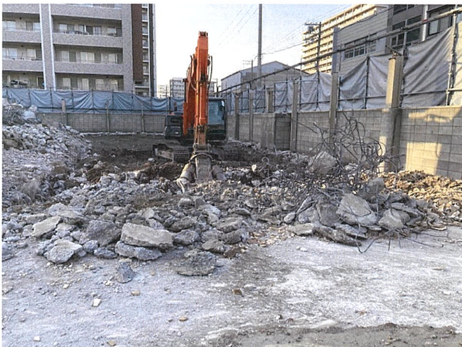
土間・基礎撤去 (参考写真)
