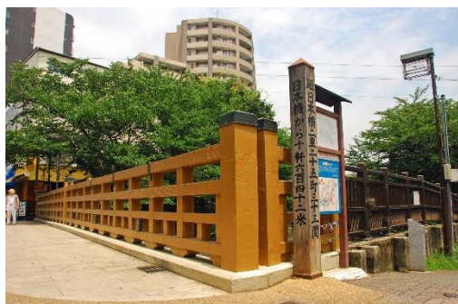
板橋（橋りょう）
