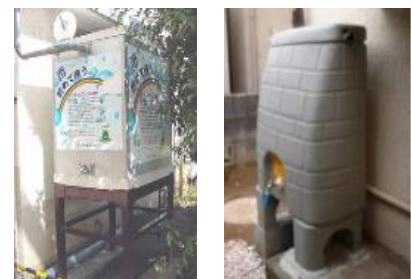
■ 雨水貯留タンク
