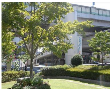
■光触媒（首都高速道路橋脚部）
