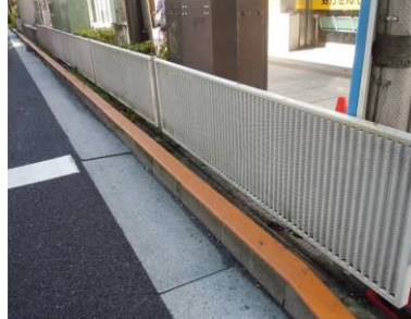
■光触媒（ガードパイプ）
