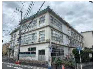
⑨北側交差点からみた旧校舎
