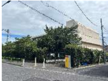
⑭南西交差点からみた敷地
