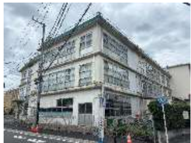
⑨北側交差点からみた旧校舎
