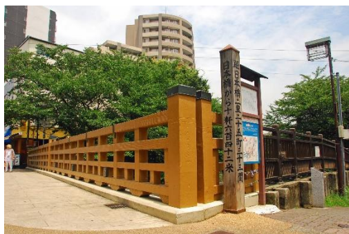
板橋（橋りょう）
