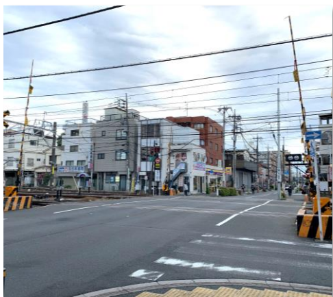
▲ 七軒家通りの踏切（第30号踏切）
