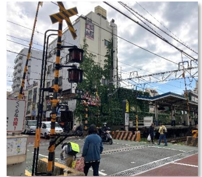
▲ ときわ台駅近傍の踏切 (第22号踏切)
