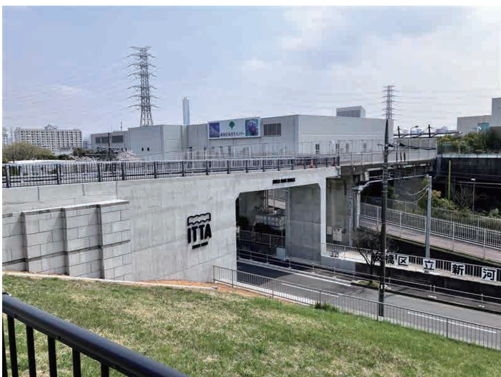
▲完成した連絡通路
