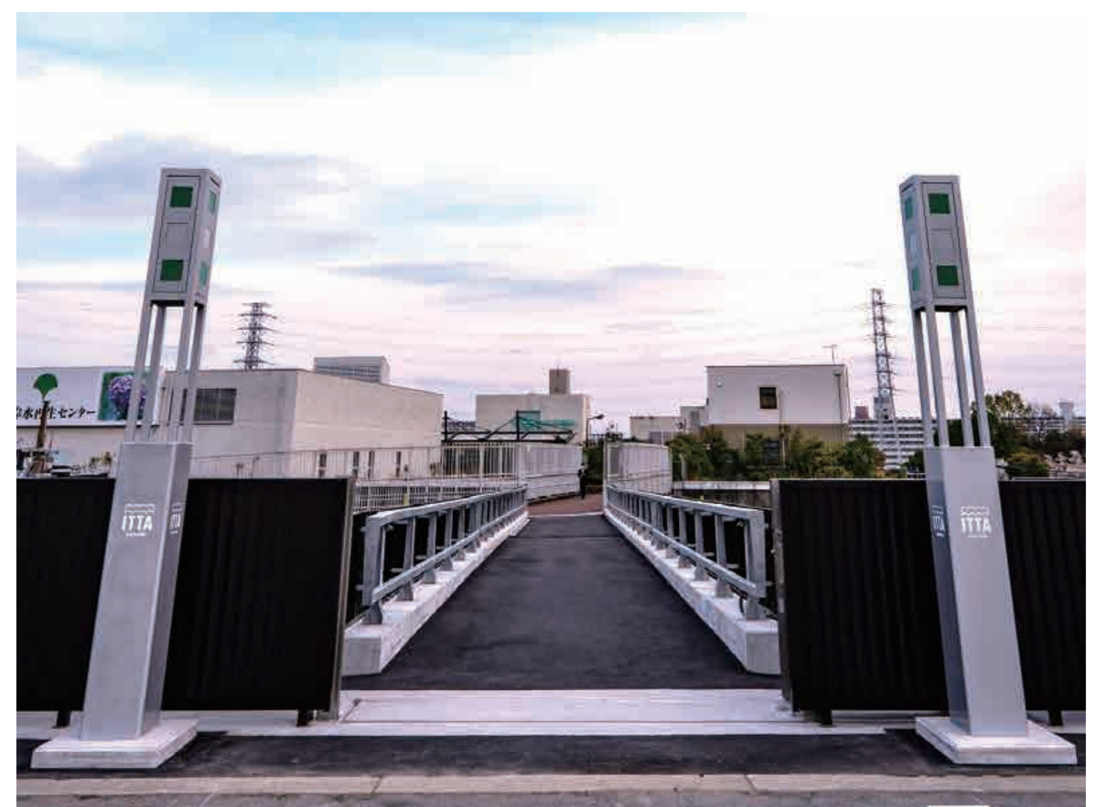
▲完成した連絡通路（荒川側より）
