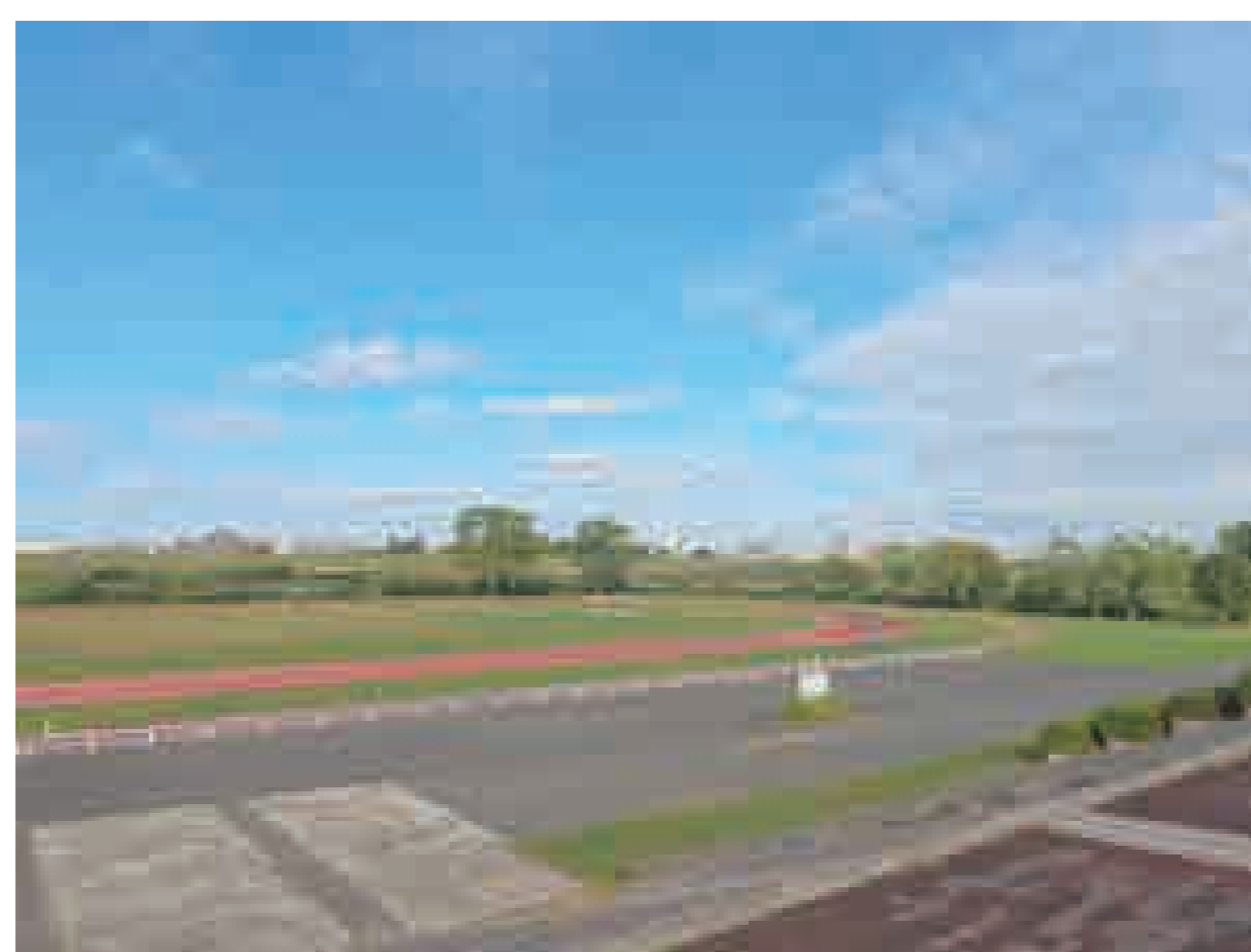
②戸田橋陸上競技場 アスファルト部分
