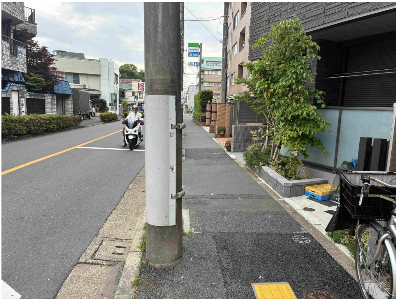
電柱で歩道が狭い様子
