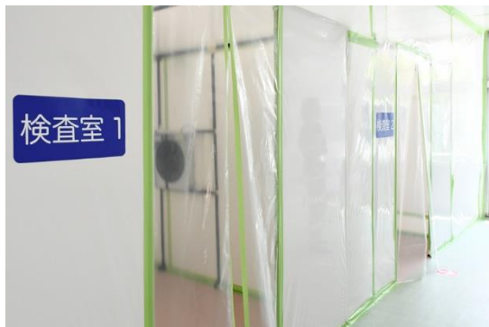
ビニールカーテンで仕切られた HEPA フィルタ簡易陰圧室構造の検査室
