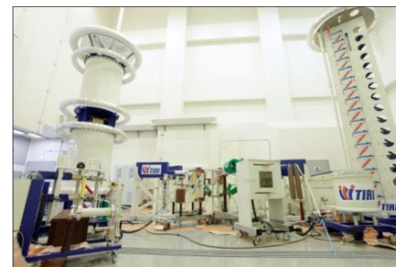
高電圧実験室
