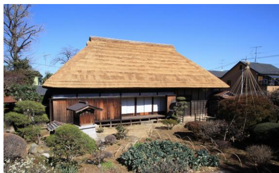
旧粕谷家（東の隠居）住宅
