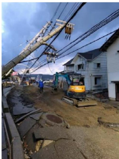
石川県輪島市 国道249号
