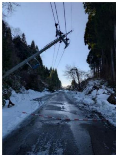
石川県輪島市 広域農道
