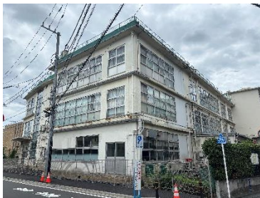
⑨北側交差点からみた旧校舎
