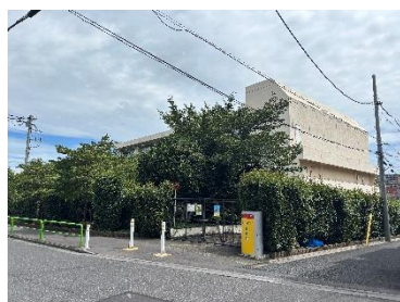
⑭南西交差点からみた敷地
