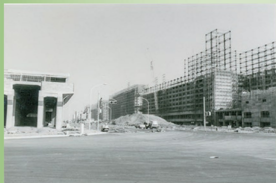
建設中の高島平団地 昭和46年(1971)
