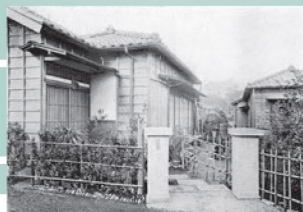
板橋第一住宅の外観 【同潤会編「昭和十三年度 事業報告」より引用】
