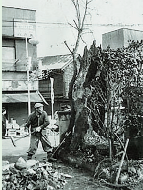
5 昭和44年(1969)2月28日(撤去当日) 撤去中(幹)。
